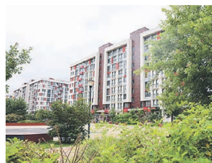
Фото: управа района Коммунарка
