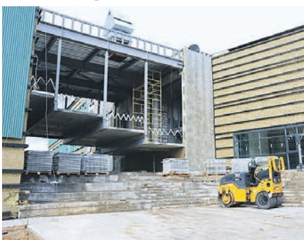
В здании образовательного комплекса завершены монолитные работы
